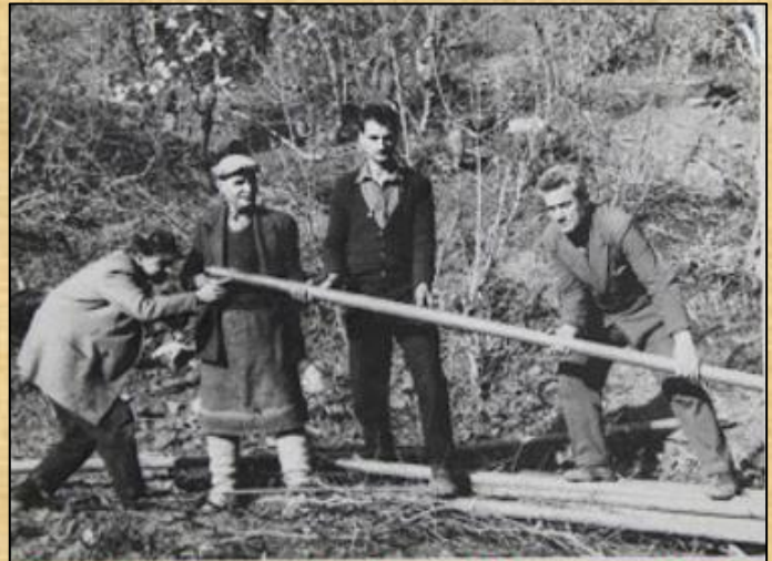
Εργασίες μεταφοράς πόσιμου ύδατος στο Χωριό Φωτογραφία από Αρχείο ΚΕΛΕΜΙΔΗ ΣΤΕΦΑΝΟΥ
