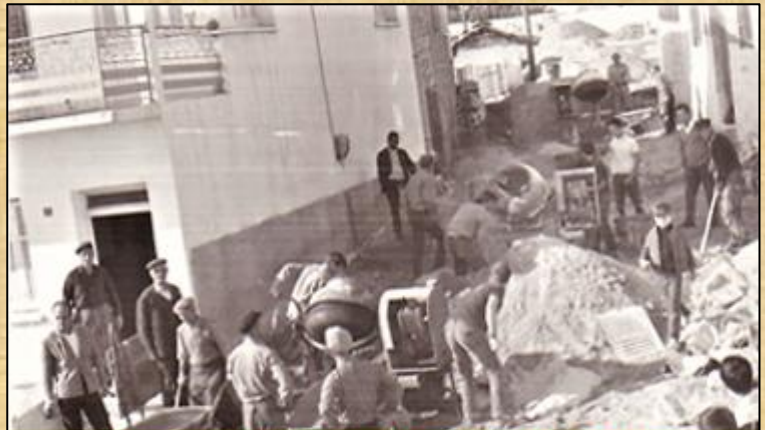
Τσιμεντόστρωση Κοινοτικού δρόμου ΟΚΤΩΒΡΙΟΣ 1971
