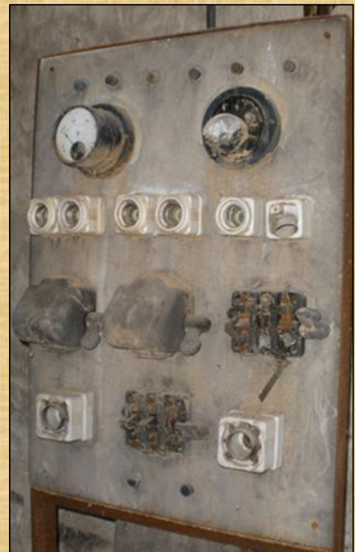
Πίνακας διανομής και οργάνων ελέγχου Ηλεκτρομηχανοστάσιου ΠΕΤΡΩΤΩΝ
