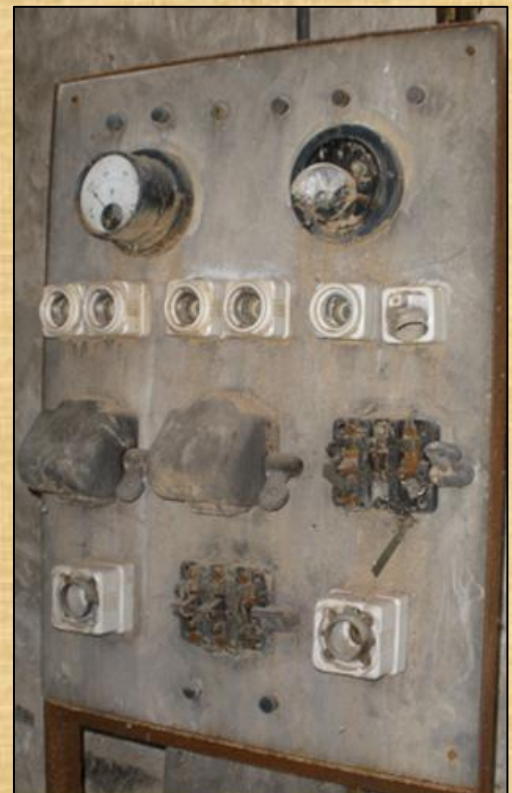
Πίνακας διανομής και οργάνων ελέγχου Ηλεκτρομηχανοστάσιου ΠΕΤΡΩΤΩΝ
